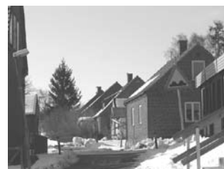
Figur 6.2: Äldre tegelbebyggelse i anslutning till kyrkan.
