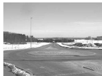
Figur 5.29: Rondellen vid Blentarpsvägen-Skurupsvägen.
