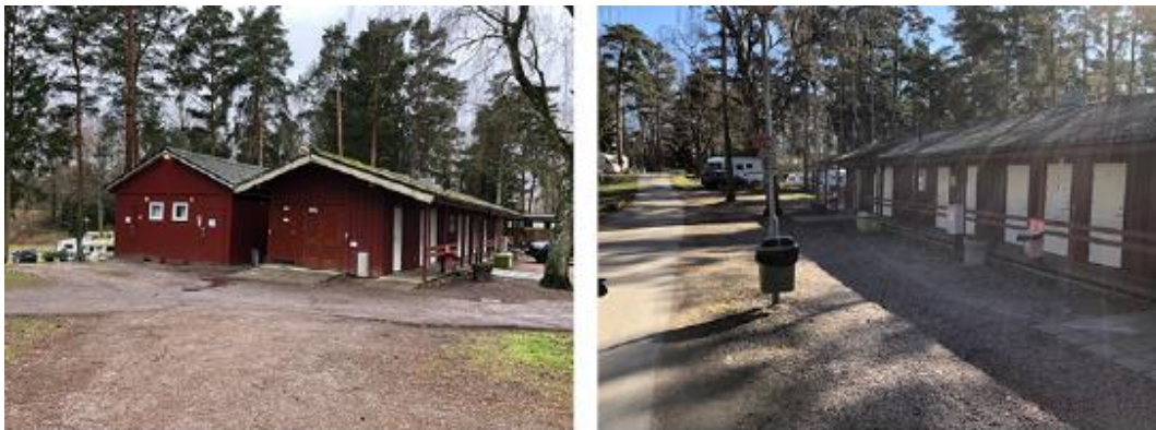
Servicebyggnader med kök, dusch, WC, tvätt, latrintömning och sophantering.
