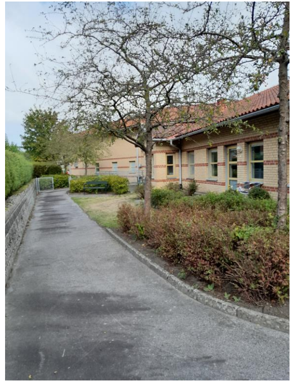
Del av byggnad mot söder.
