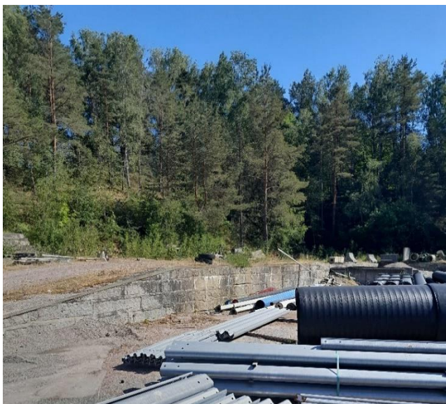
Planområdets östra del sett från norr. Stenkanten som bevaras i planförslaget och i bakgrunden den befintliga trädbevuxna slänten som också bevaras. Fotografi: Maja Håkansson
