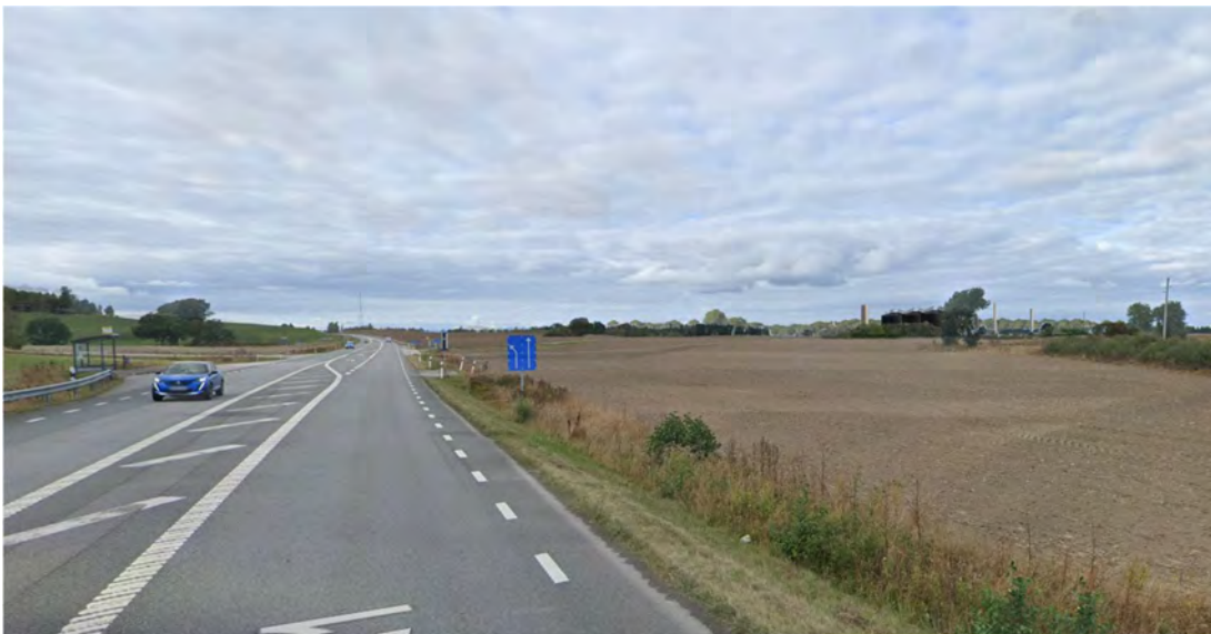
Figur 14. Vy från väg 11 sydost. WSP 2023.
