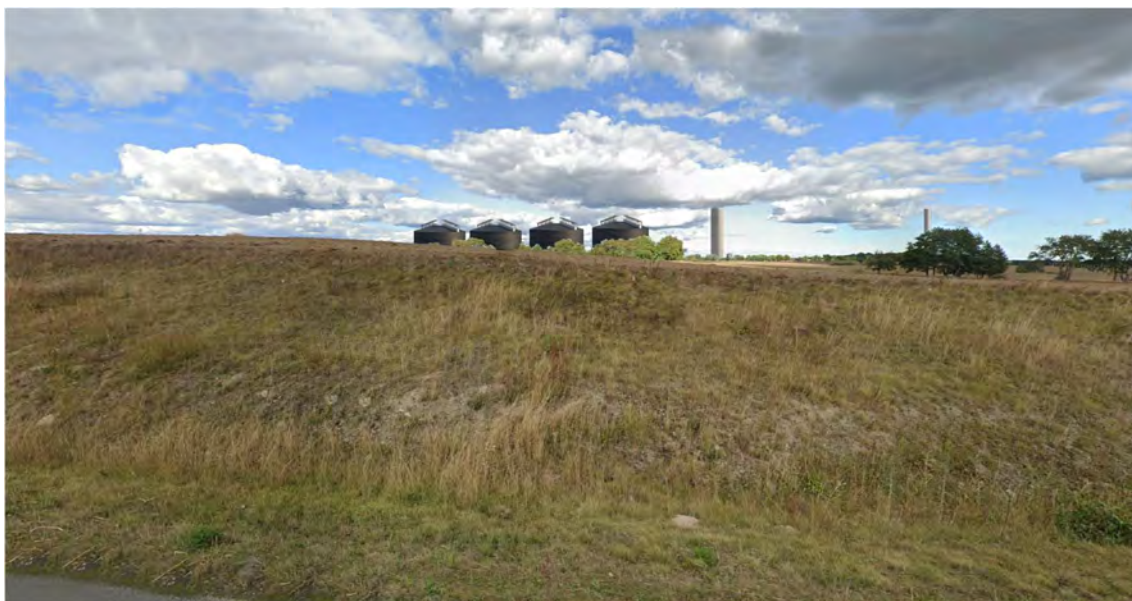
Figur 15. Vy från väg 11 i söder mot norr. Här går väg 11 i skärning, och vägens slänter minskar anläggningens exponering. WSP 2023.
