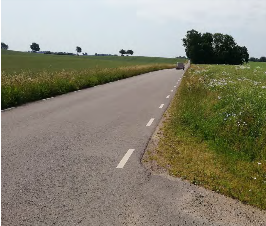
Figur 5: Röddingevägen söderut i riktning mot Väg 11 (foto: WSP)
