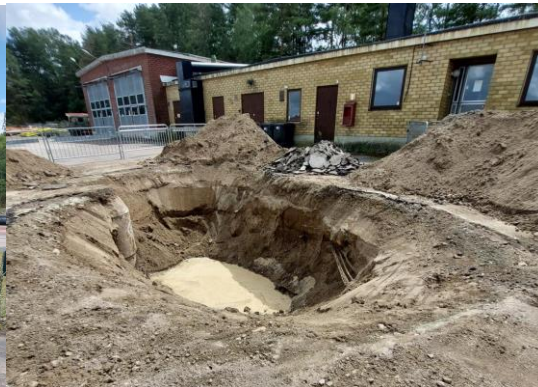
Figur 7. Visar slutligt schakt efter att cisternen lyfts ur. Fotot är taget i sydöstlig riktning.
