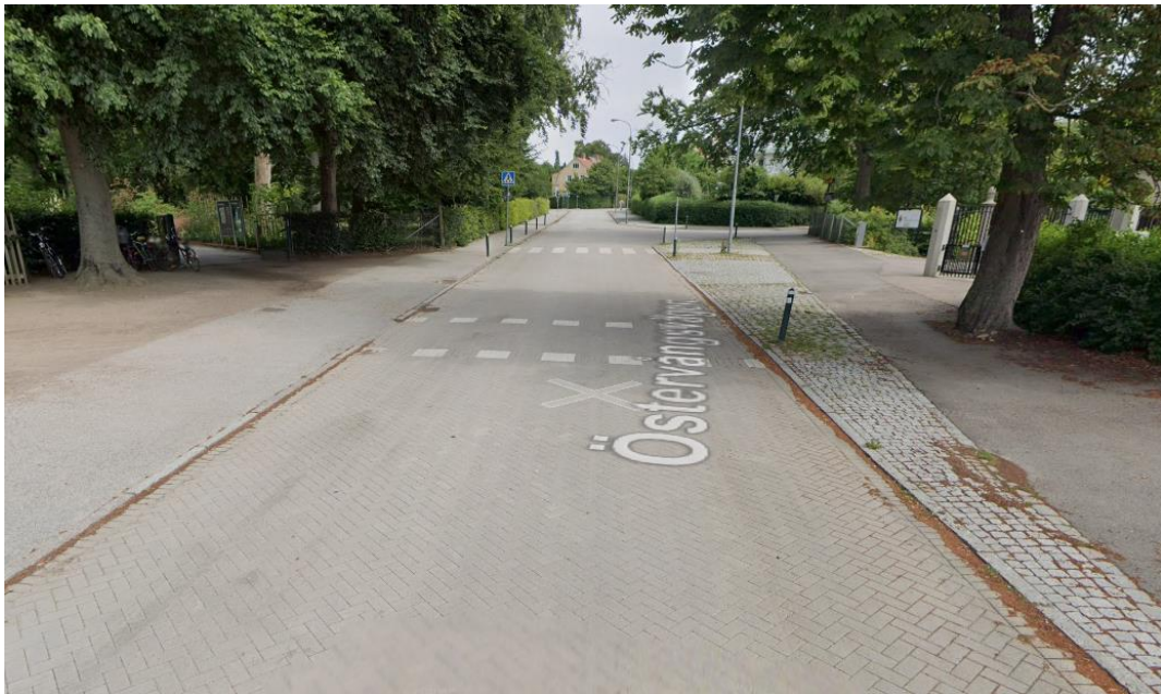
Figur 18. Exempel på längre sammanhängande upphöjning med passage, övergångsställe och korsning från Östervångsvägen i Lund (Google Maps, 2024).
