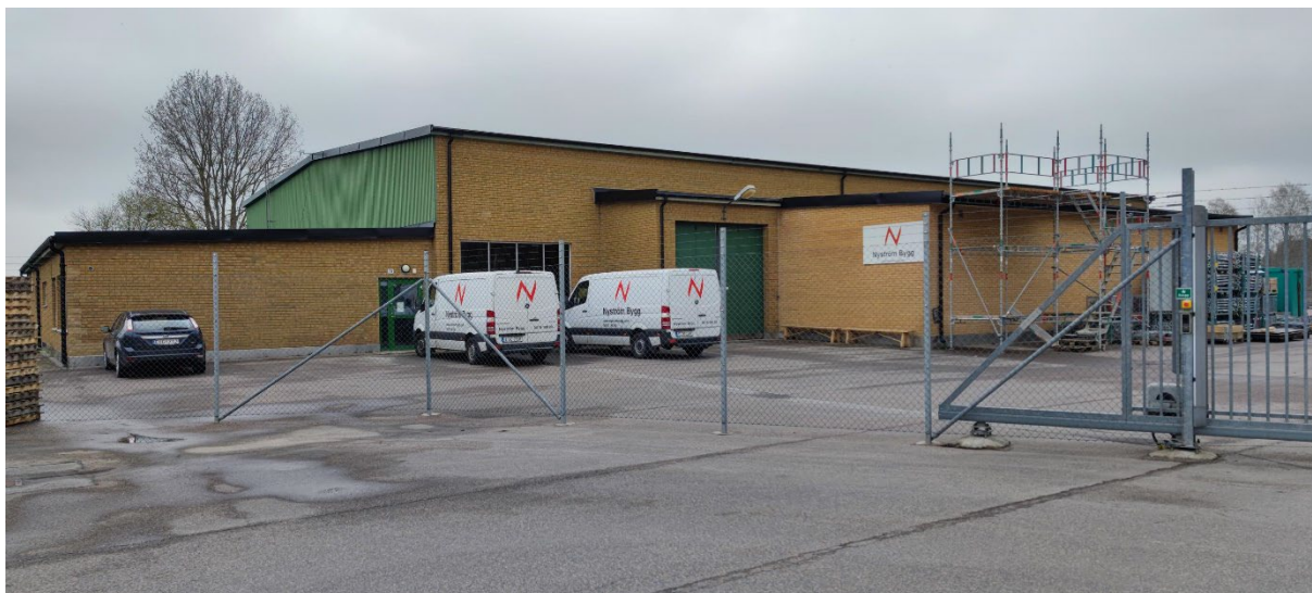
Fig 11. Fastighetens huvudbyggnad. Fotot är taget från Stamhem 3 vid ingången till Stamhem 6.
